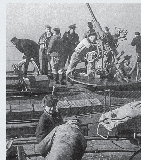
▲ Цеха судостроительного завода № 402. В начале 40-х годов ▼ Монтаж зенитной установки на большом морском охотнике
