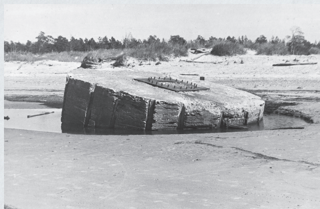
▲ Фундамент под орудия батареи на острове Ягры. 1987 год. В годы войны на таких основаниях располагались 152-мм орудия системы КАНЗ
